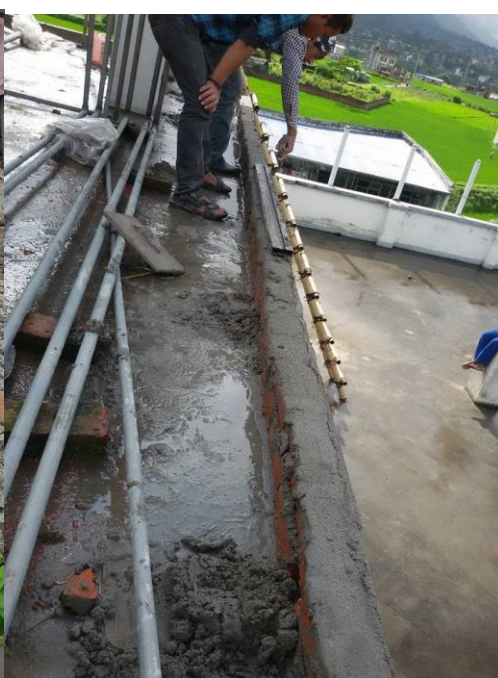
Protection de la terrasse pour la pluie
