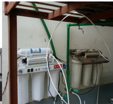
Remplacements des filtres UV
