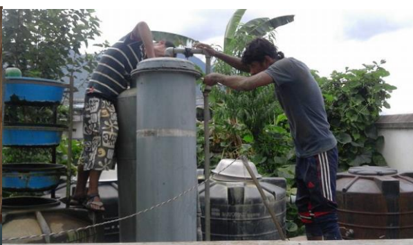
Entretien des filtres pour l'eau du forage
