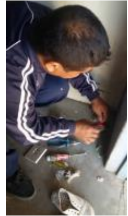
Electricité à CH
